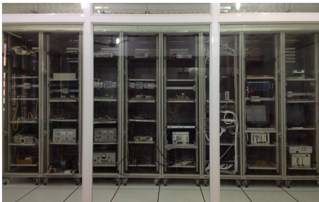
Рис. 1. Центр управления и средств автоматизации.
